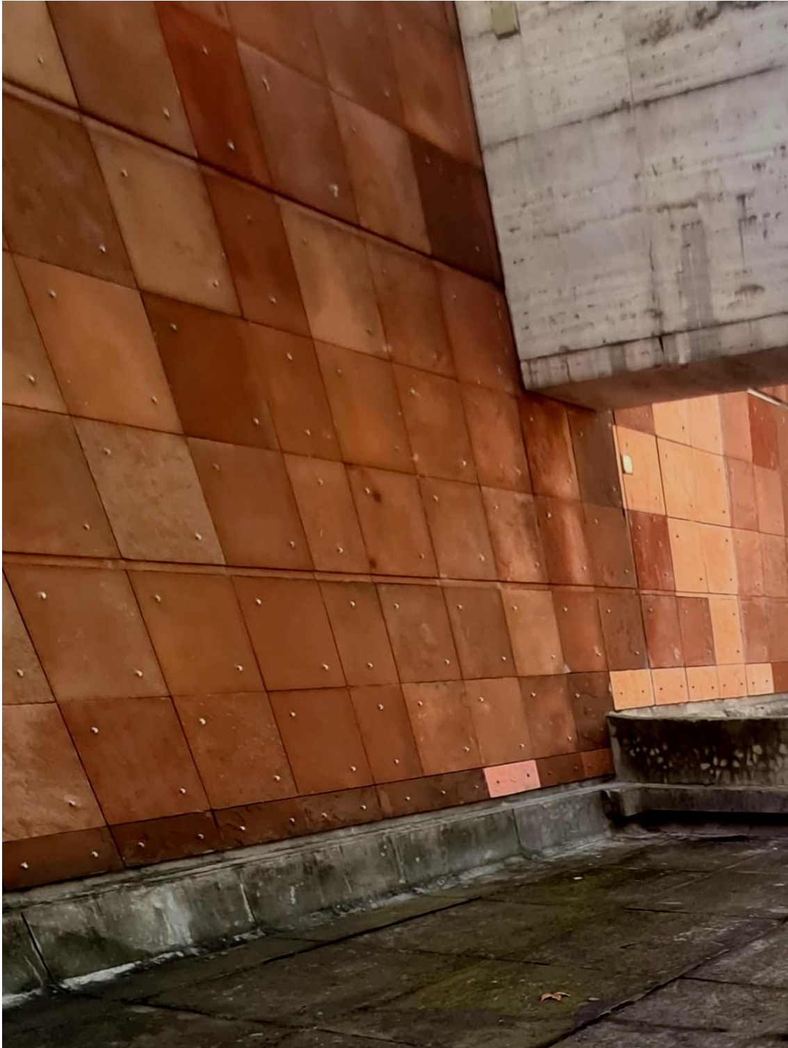
EJEMPLO DE SOLUCIÓN APLICADA EN PACAS ARENISCAS EXTERIORES SEGÚN DETALLAN ANEXOS Y MEMORIAS
